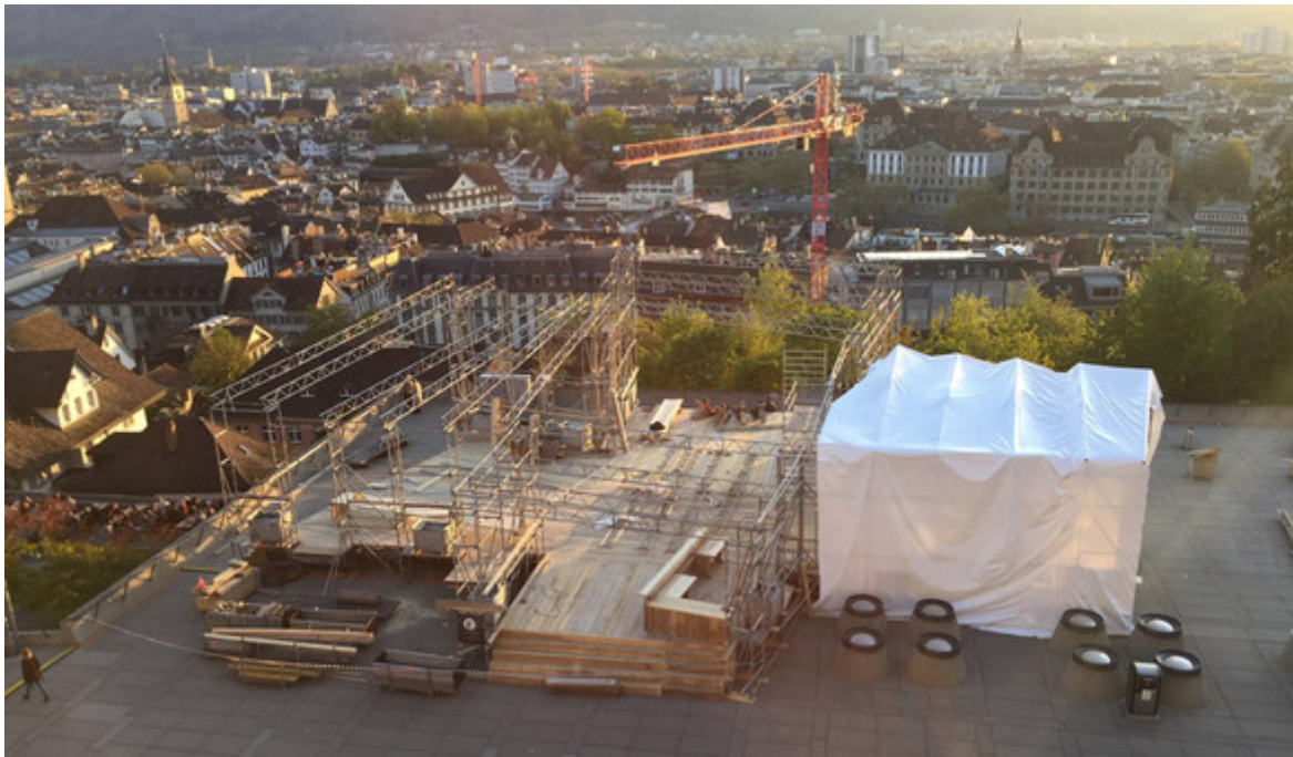
Blick auf die Baustelle des Tastelab in Zürich.
